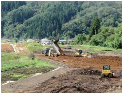
生まれ変わる荒廃地
